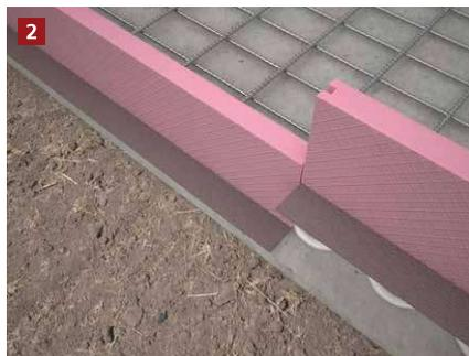
Darauffin wird die Bodenplattenrandschalung sorgfältig in den Schaum gedrückt. Je nach Untergrund: Fuß nach außen oder innen.
