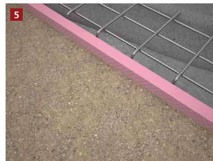
Der Betonvorgang wird begonnen. (Bei Fuß außen: Schalung gegebenenfalls weiter mit Erde / Sand anfüllen.)
