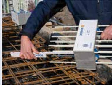
4. Kontrolle messung der Stablängen entsprechend der Einbindelänge.
