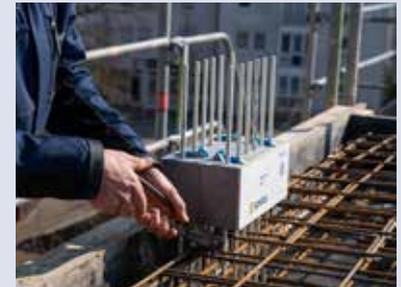
6. Anbinden der Combar® Stäbe an der Deckenbewehrung für einen sicheren Stand während des Betoniervorgangs.
