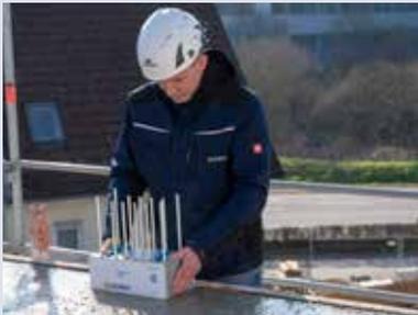
Alternativ kann Schoeck Isokorb® CXT Typ A auch direkt in den Frischbeton eingesetzt werden.
