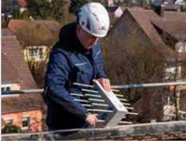
3. Anpassen der vier längsverschieblichen Eckstäbe an die Deckendicke durch drehen und schieben der Combar® Stäbe.
