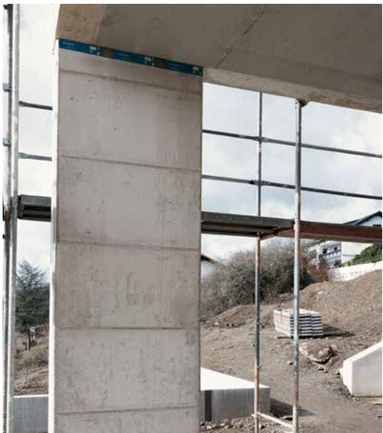
Sconnex® ermöglicht schlanke Wandvorlage in Sichtbetonoptik bei nachhaltig gelöster Wärmebrücke.
