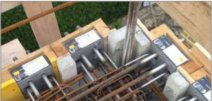
Abb. 33: Einbau bei Außenecken
