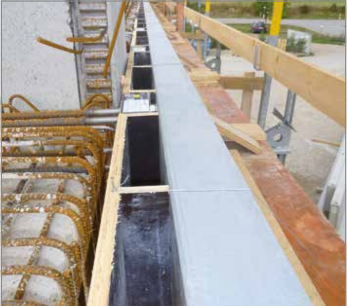
Abb. 29: Alu-Schalungshilfe in eingebautem Zustand
