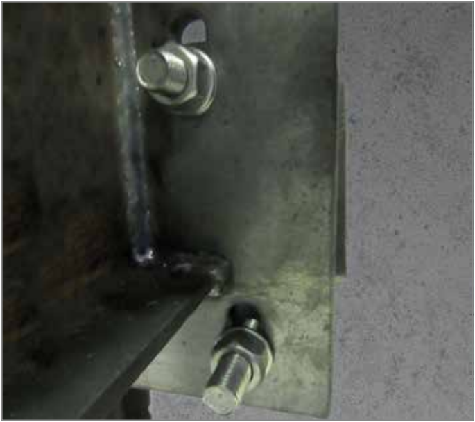
Abb. 38: Vertikale Langlöcher an der bauseitigen Kopfplatte zum vertikalen Toleranzausgleich
