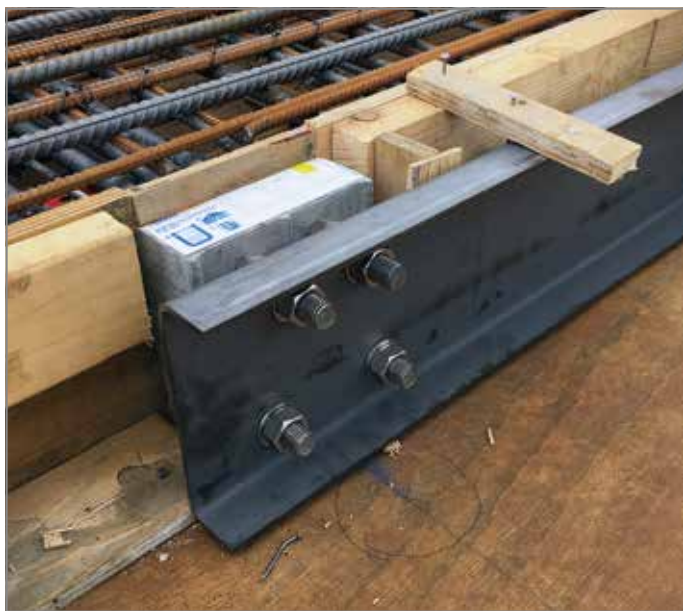
Abb. 30: Verwendung einer Stahl-Schalungshilfe
