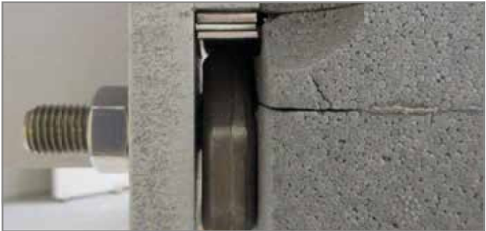
Abb. 37: Auflegen der Stahlkonstruktion mit den am Produkt angebrachten Unterlegplättchen zum Höhenausgleich
