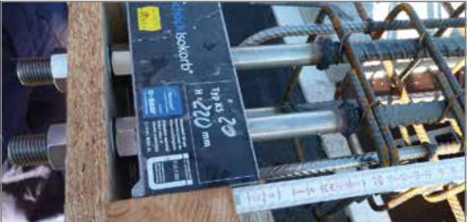
Abb. 25: Verwendung der optionalen Einbauhilfe von Schöck beim Einsatz in Verbindung mit Wärmedämmverbundsystem. Ansicht zeigt Befestigung an der Deckenrandchalung
