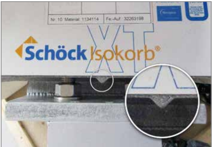
Abb. 21: Mittenkennzeichnung beim Schöck Isokorb® T/XT Typ SK
