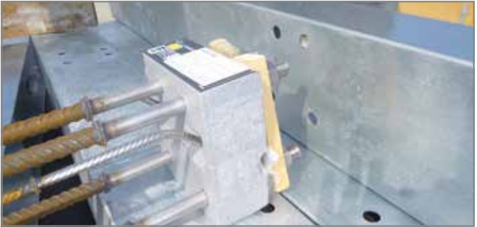
Abb. 28: Verwendung einer Alu-Schalungshilfe
