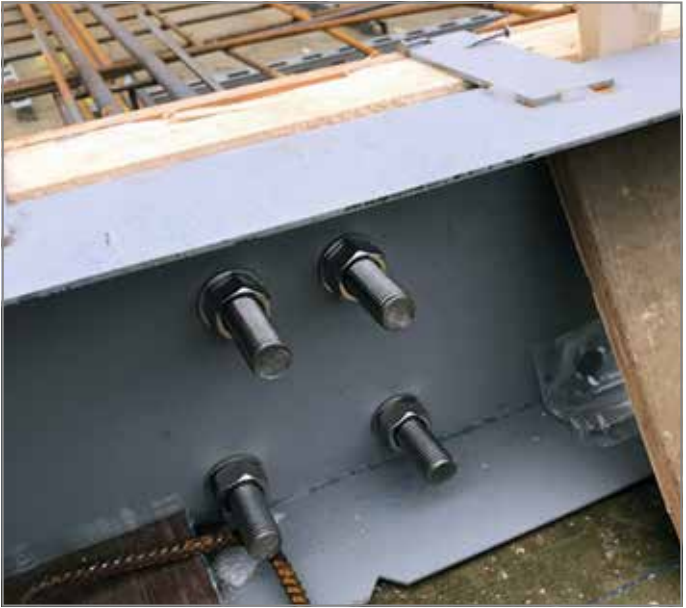
Abb. 19: Schöck Isokorb® XT Typ SK mit bauseitiger Einbauhilfe, U-Profil aus Stahl mit exaktem Lochbild des Korbes
