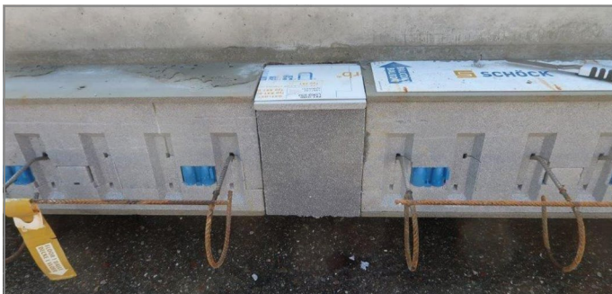
Abb. 56: Transportankerlücke mit Schöck Isokorb® XT Typ Z schließen
